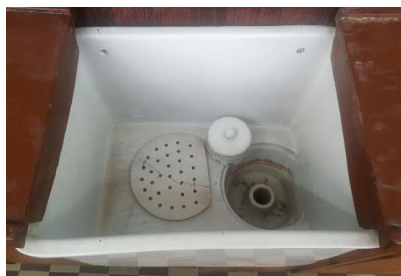
Слика ?. Изглед на кисело-отпорен порцелански мијалник со вграден сифон и шематски приказ на сифонот со неговите составни делови.
