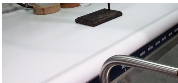
Слика ? Рабови на работните површини коиго спречуваат излевањето на истурените раствори и хемикалии.
